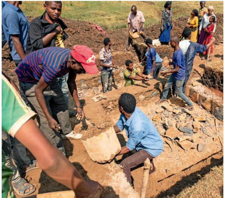
Partizipation von Anfang an: Bei allen unseren Projekten, wie hier beim Bau einer Quelfassung, ist die Bevölkerung beteiligt und packt mit an.
