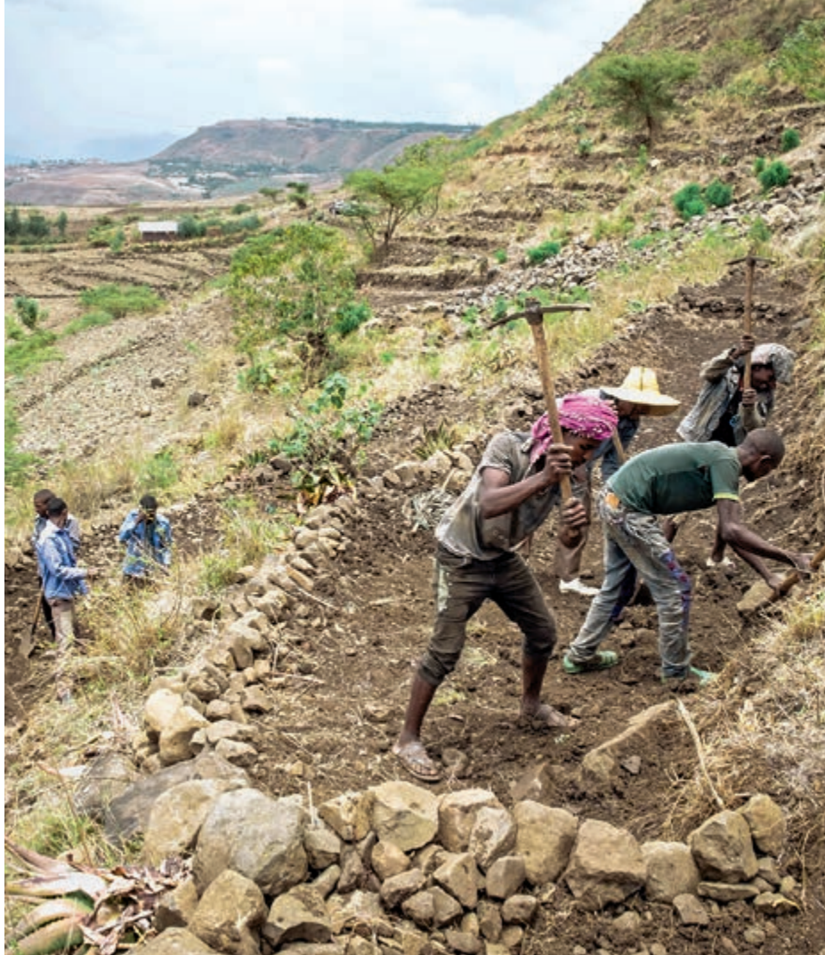
Gut voran geht es in dem Wiederbewaldungsprojekt in Wogdi in Kooperation mit der Heinz Sielmann Stiftung. Die sichtbaren Erfolge motivieren die Bauern, mit vereinten Kräften weitere Terrassen anzulegen.
