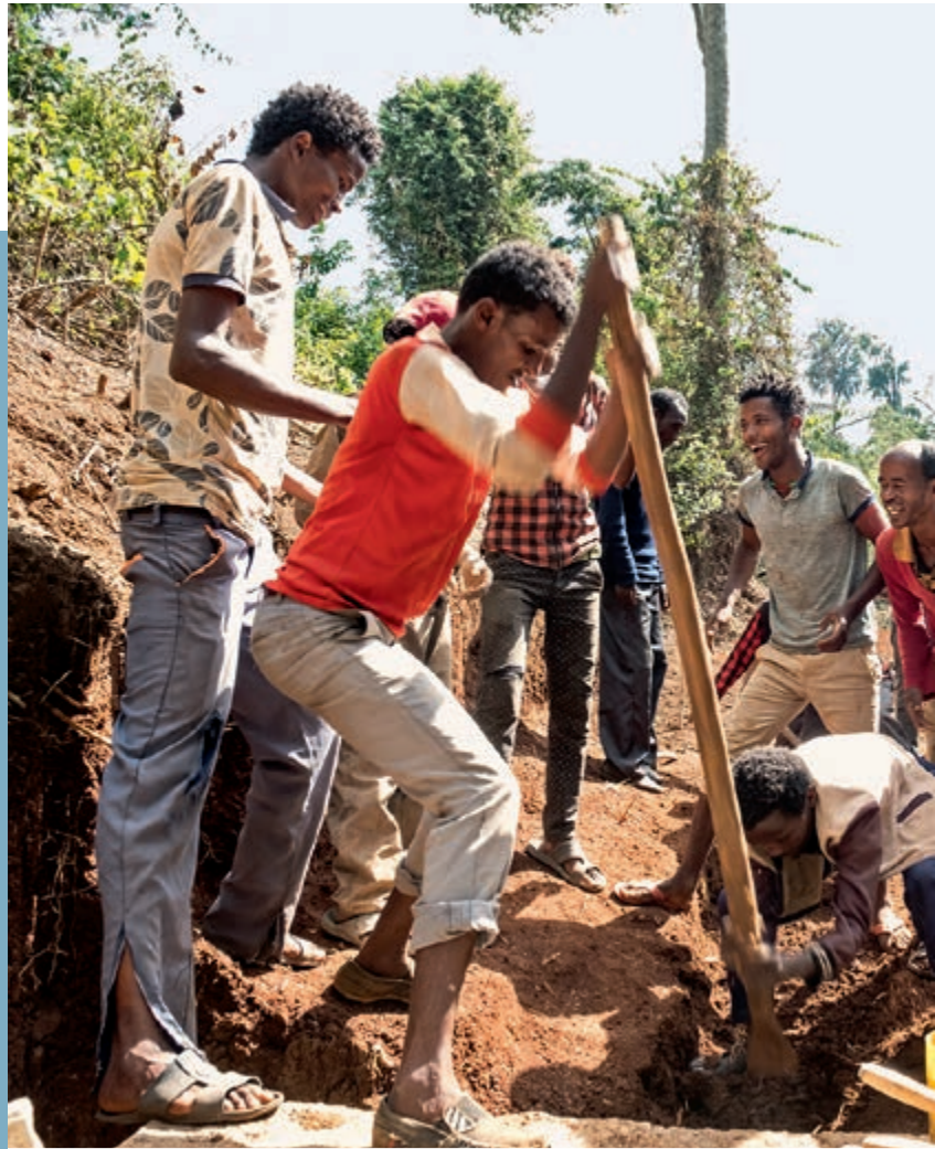
Mit vielen Helfern sind die Gräben für die Wasserleitungen bald ausgehoben.
