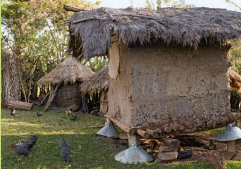
Weder für Nässe noch für Ratten zugänglich: In solchen verbesserten Speichern ist das Getreide sicher gelagert.
