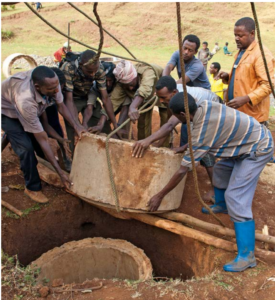
Projektgebiet Borecha: Viele packen mit an beim Einsetzen des letzten Brunnenrings.
