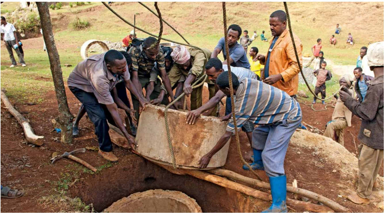
Alle packen mit an: Brunnenbau in Borecha.
