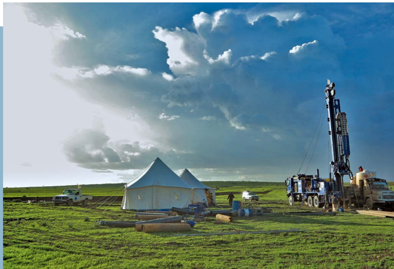
Das organisationseigene Tiefbohrgerät hatte bereits mehrere Einsätze, unter anderem im dürrgeplagten Somali. 4.500 Menschen sollen dort künftig mit sauberem Wasser versorgt werden.
