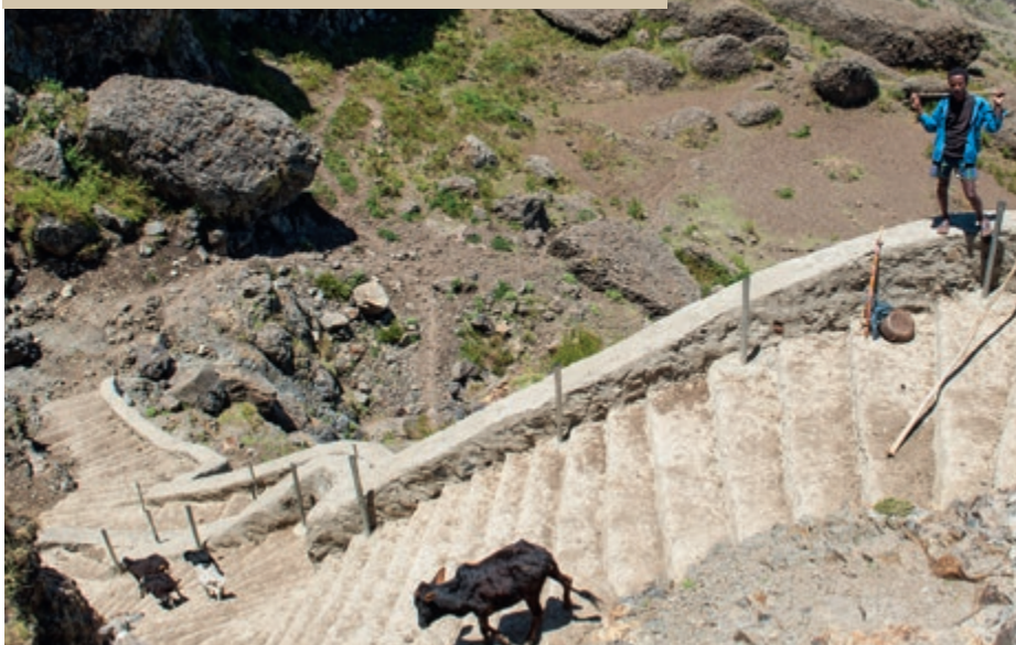
Treppenbau bei Lemmi.
