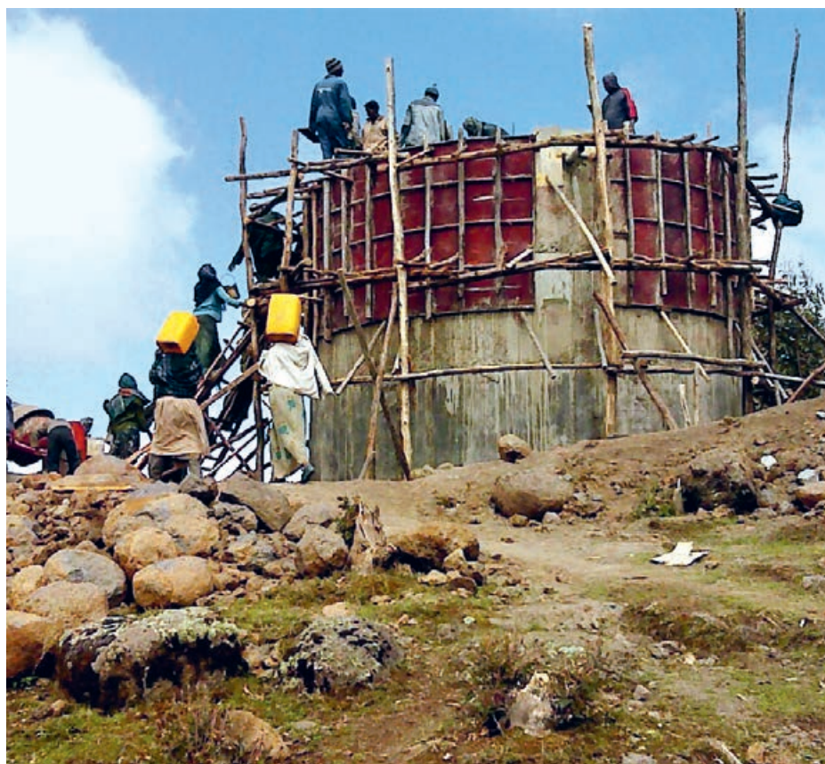
Beim Bau des Wasserreservoirs helfen alle mit.
