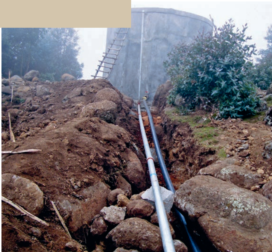
Eine 1.600 Meter lange Steigleitung führt hinauf zum Wasserreservoir.
