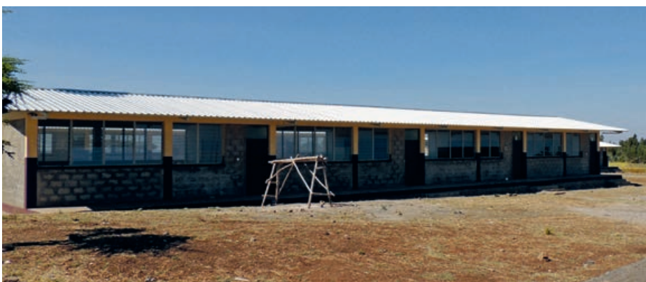
Unterrichtsgebäude der alten und der neuen Schule von Makefta.
